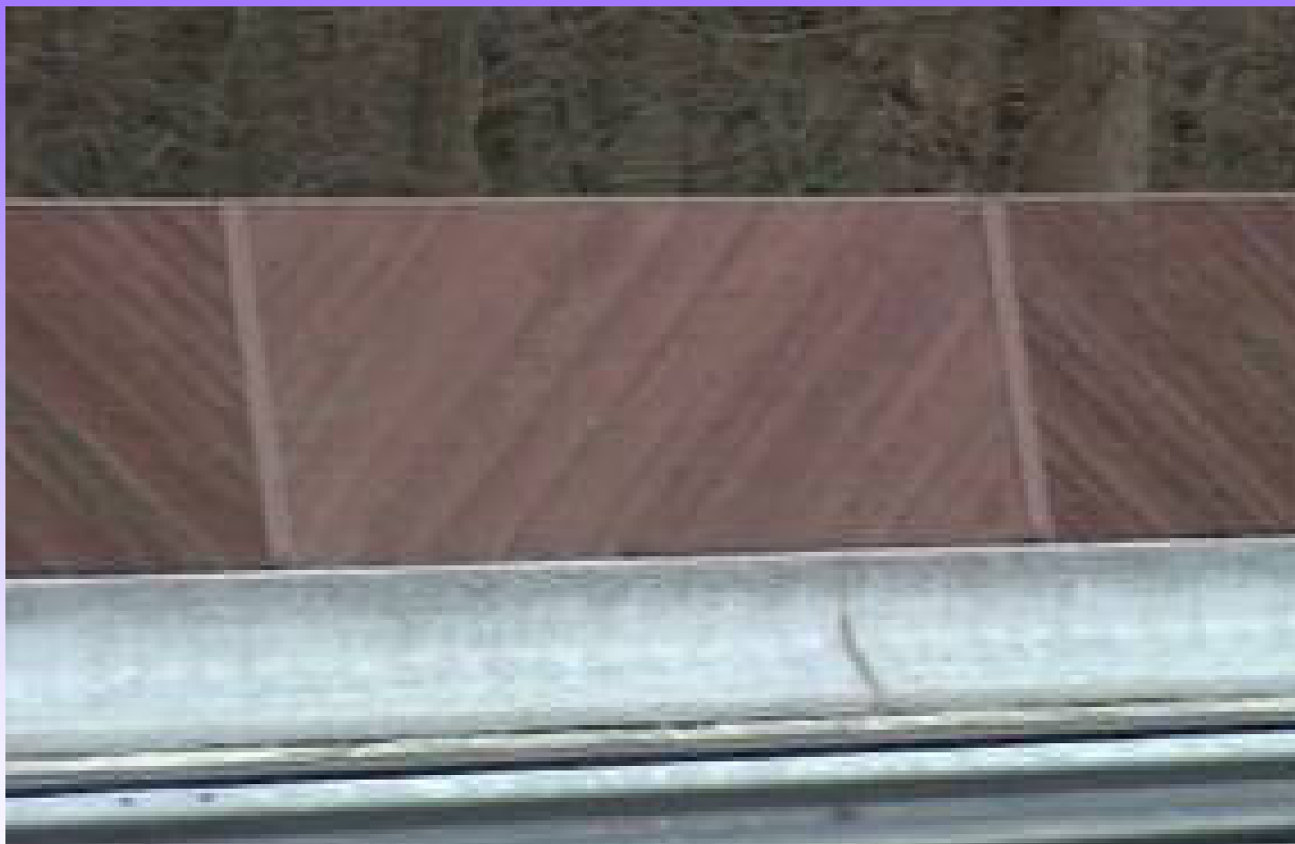
دیوار مانع صوتی در حاشیه اتوبان ساخته شده از کاج نروژی در سال 1998
